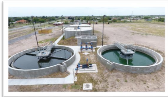
La Planta Regional de Tratamiento de Aguas Residuales de Donna comenzó a funcionar el 5 de mayo.
