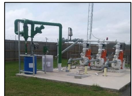
Estación de Bombeo D, ubicada en Tower Road, bombea las aguas residuales de un área baja a una elevación más alta para que pueda continuar su flujo hacia la planta de tratamiento.
